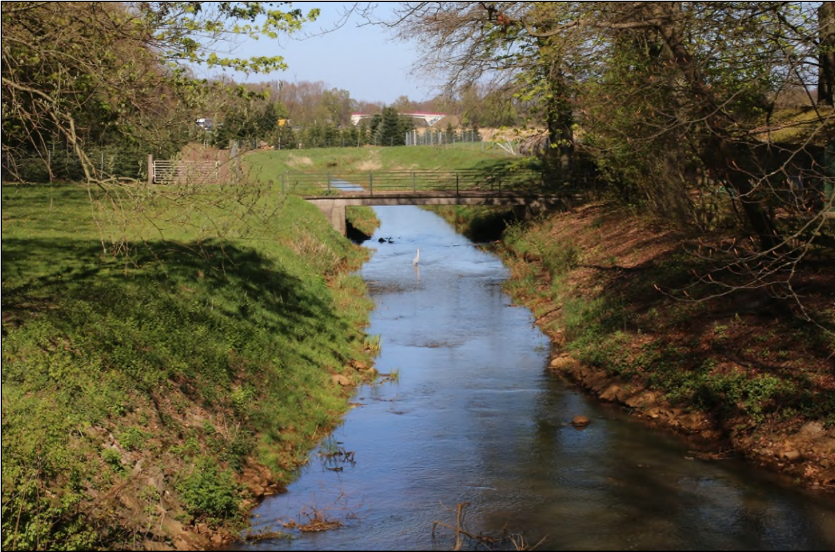
Abb. 3: Dünsener Bach im Umgestaltungsbereich unterhalb des Wehres.
