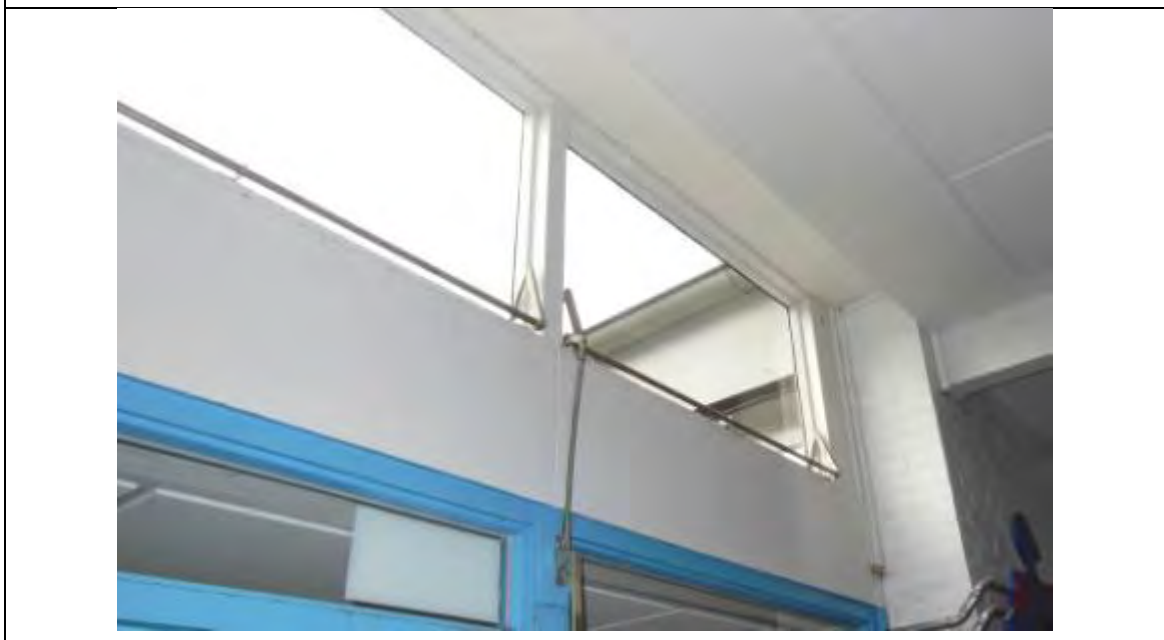
Undichte Oberlichter mit einfacher Verglasung
