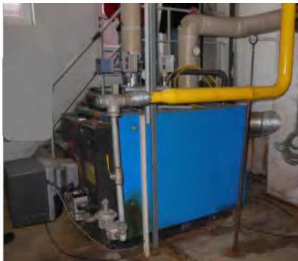
Weil der Brennwertkessel defekt ist, wurde er ausgebaut und der alte Gebläsekessel von 1981 wieder in Betrieb genommen.
