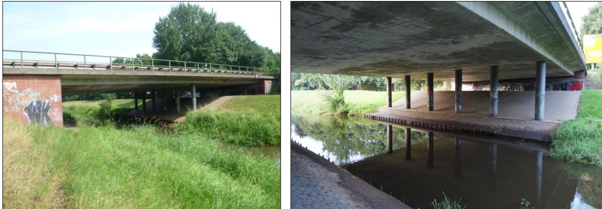
Abbildung 8: Bestehendes Bauwerk 443 (Fotos: K. Otte & C. Neuhaus (2015))
