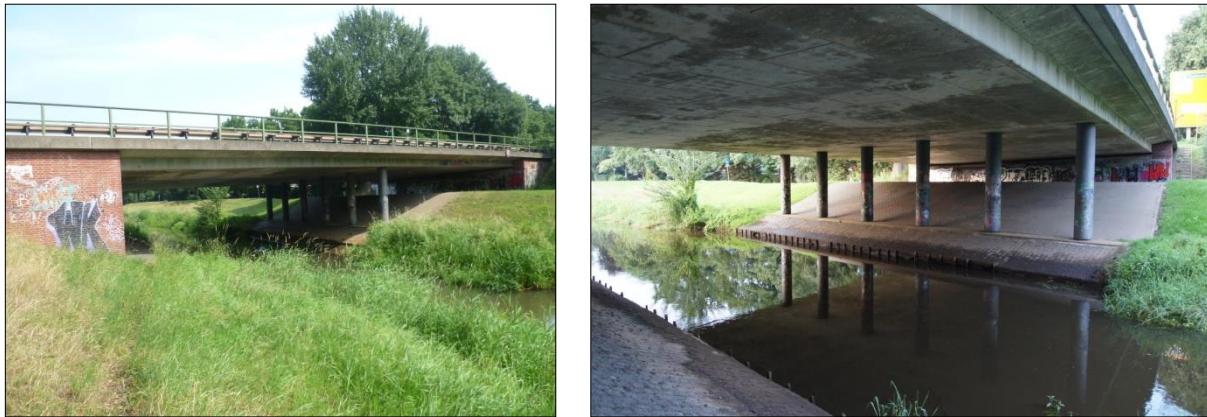
Abbildung 7: Bestehendes Bauwerk 443 (Fotos: K. Otte & C. Neuhaus (2015))
